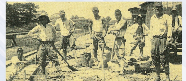
鹿児島本線路床工事、鳥栖倉庫附近
